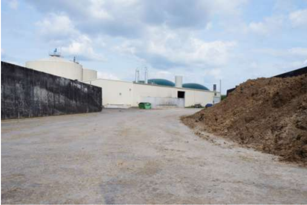
Ein Blick auf die Anlage
